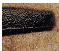
B Sduit tectyl op schoon beton
