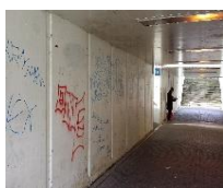
A Inkt en stift op prefab betonwand.
